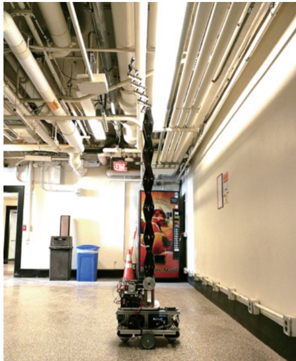
写真2 アプリケーション例。配管の点検作業。 Photo 2 Example application: inspection task
